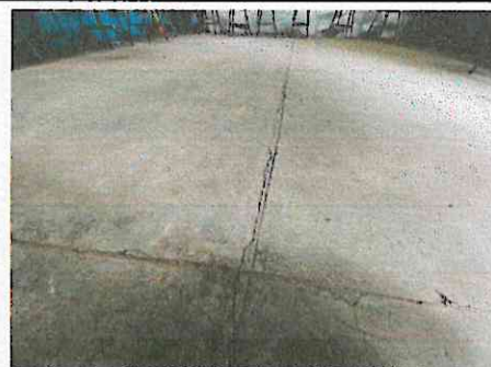
Foto 6: EN ESTA PARTE SE PRESENTAN GRETADURAS EN EL PISO, ESTO POR EL PASO DE LOS AÑOS, YA QUE HACE TIEMPOS QUE SE LLEVÓ A CABO DICHO PROYECTO.
