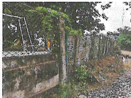
Foto 2: HACE AÑOS SE INICIÓ CON UN MURO PERIMETRAL COMPUESTO DE: CIMIENTO DE CONCRETO, BLOCK Y MAYA PARA CIRCULAR EL AREA DE LA ESCUELA POR EL AREA DE LA CANCHA, AREA QUE COLINDA CON LA CARRETERA PRINCIPAL HACIA CHIQUMULILLA, EL OBJETIVO ES CULMINAR DICHO MURO YA QUE CONTAMOS YA CON EL PRINCIPIO.
